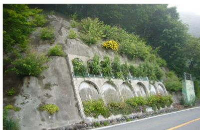
アーチ&ポケット工法による緑化
