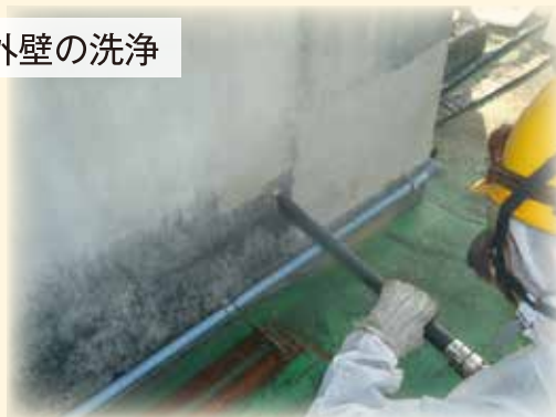
・電気機器の洗浄
