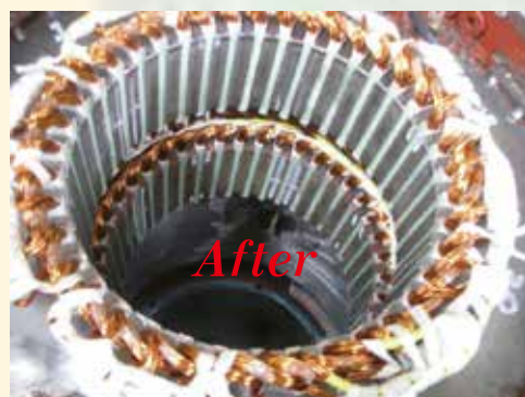
・110kw自励式発電機巻替え工事
